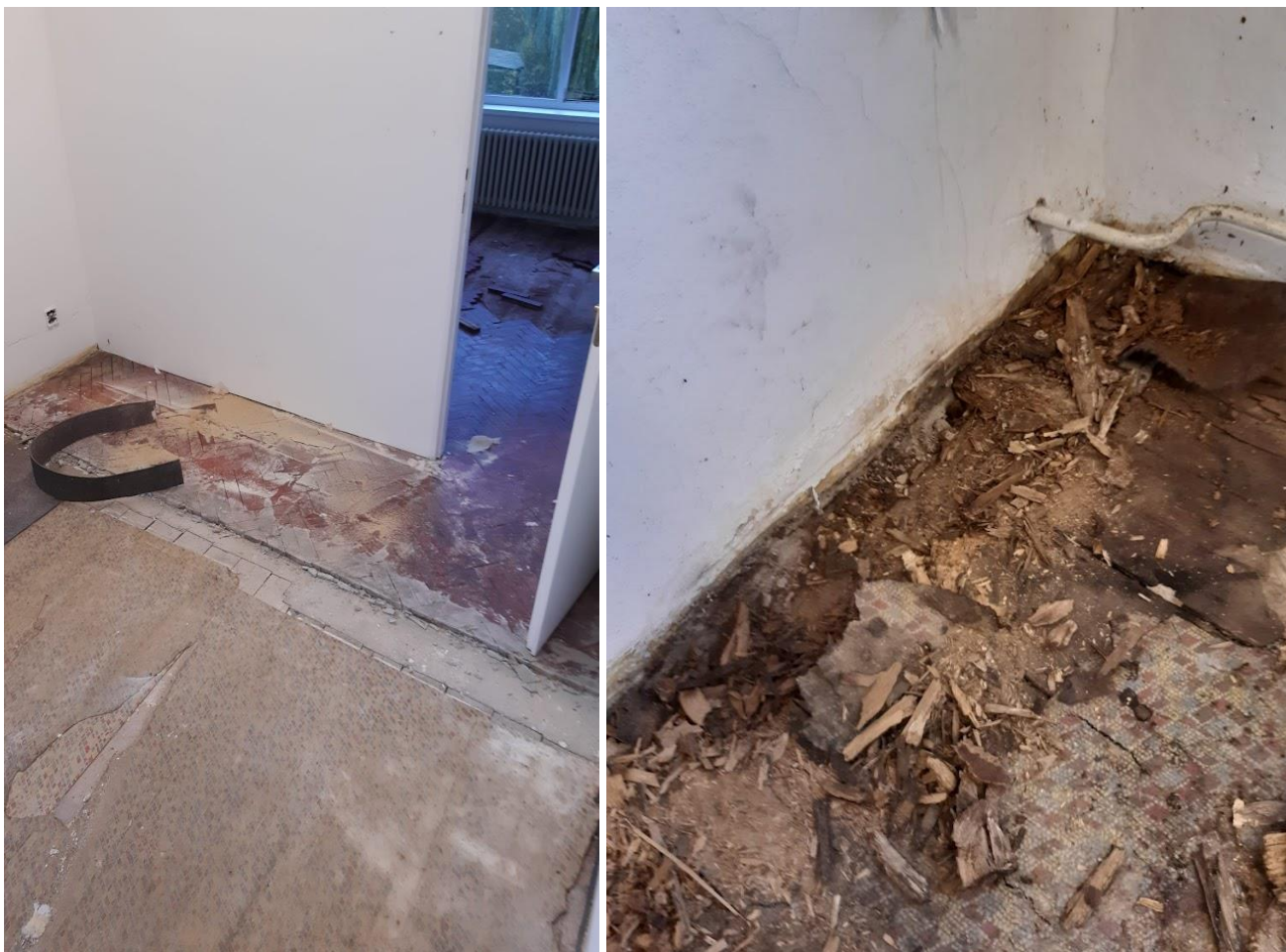
Stav podlahy ve sborovně a kanceláři zástupce ředitele – před rekonstrukcí
