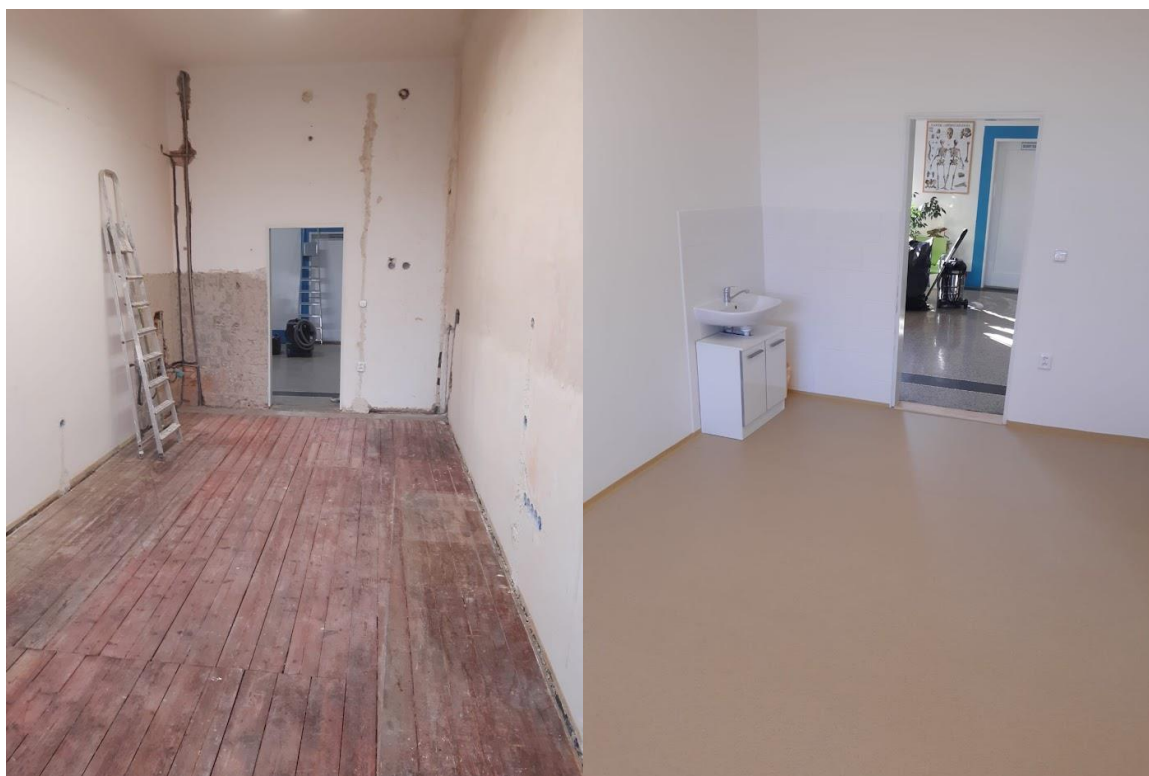
Kabinet ve 2. patře před rekonstrukcí a po rekonstrukci
