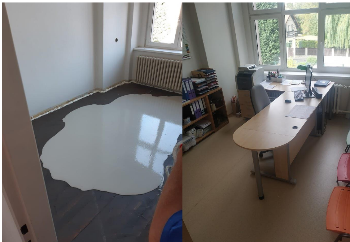
Kancelář zástupce ředitele během rekonstrukce a po rekonstrukci
